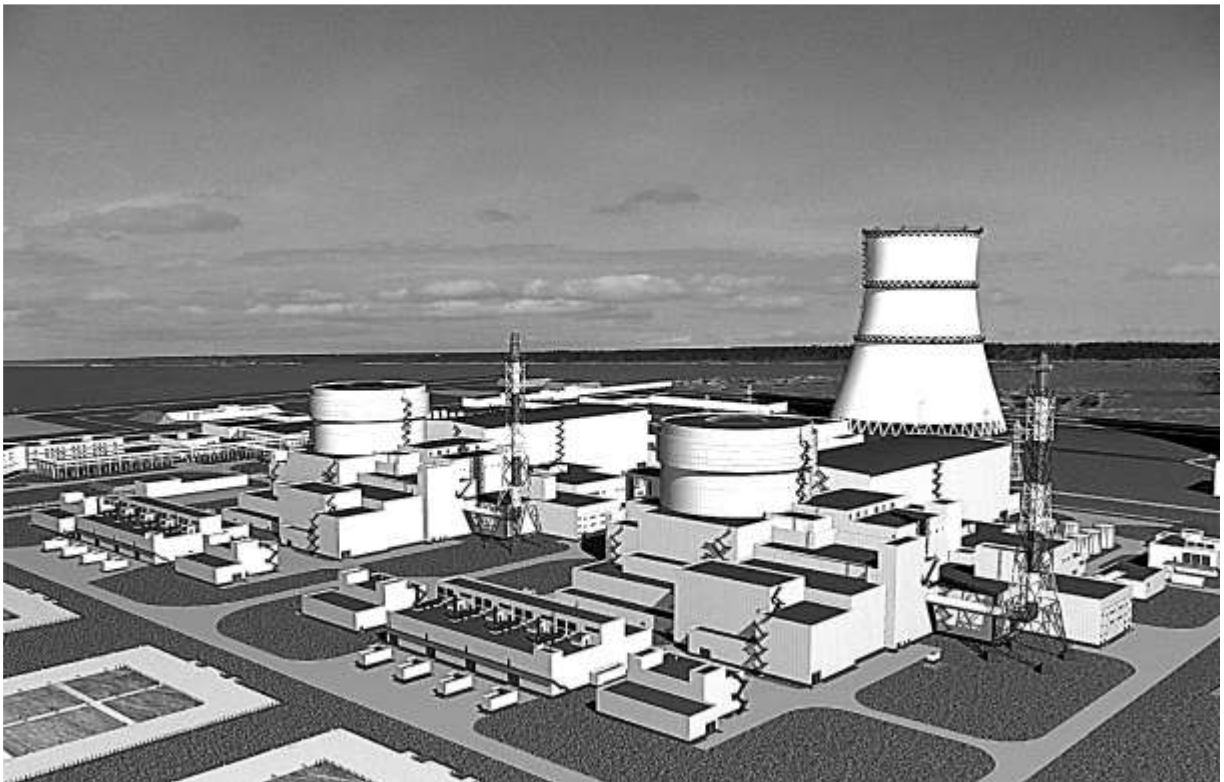
Белорусская атомная электростанция (макет)
